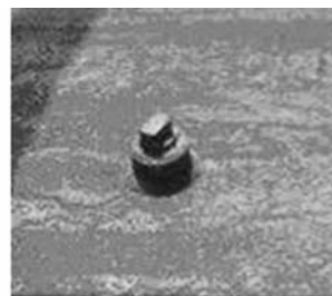
图12 使用多年一直 未打开的通气孔
