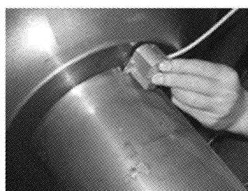
图3 勒伤现场检测
