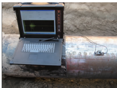
图14 管道焊缝残余应力检测现场图
