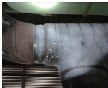
图 1 带台阶异形结构焊缝宏观形貌
