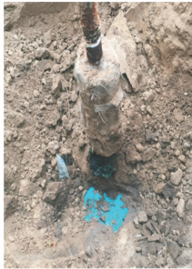
图12 焊接式打孔盗油装置开挖验证现场
