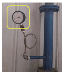
(a) 压缩空气压力表显示 0.3 MPa
