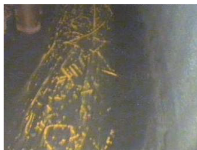
图5 远程视频检查图像(外环廊锈迹)
